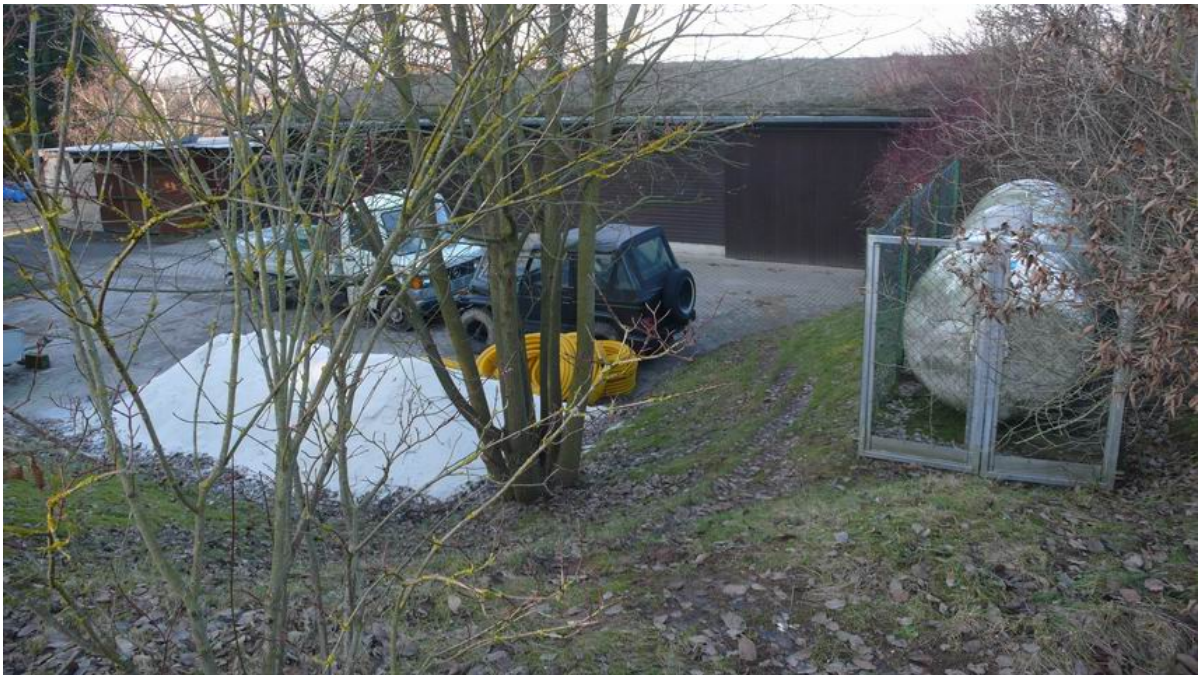
Blick von Südosten auf den Änderungsbereich 1
