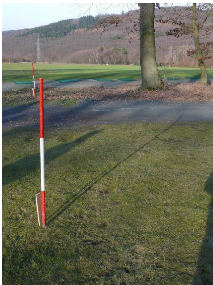
Änderungsbereich 3 mit abgesteckter östlicher Kante des geplanten Gebäudes
