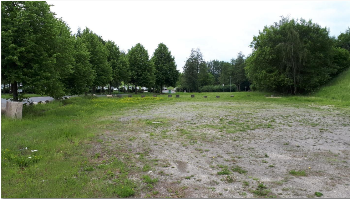
Abbildung 3: Parkplatzfläche mit wassergebundener Decke und randlich entstandener Ruderalvegetation. Quelle: GFP
